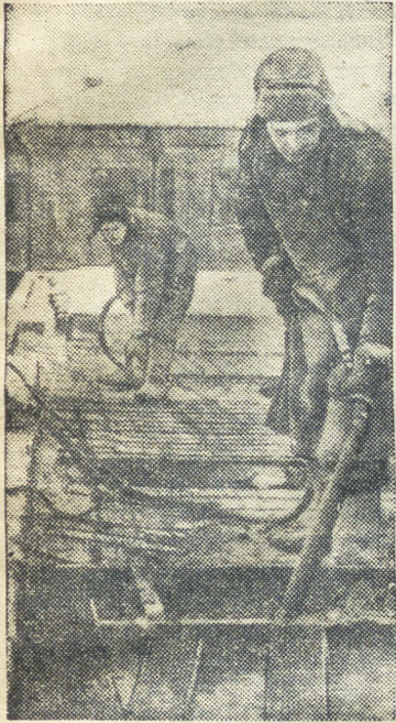
За последние годы на строительных работах по укладке бетона широко применяются вибраторы. Это устройство намного повышает качество работ. НА СНИМКЕ: молодой строитель А. Гайфутдинов ведет укладку бетона вибратором на вновь строящемся доме в городе Полеском. Снимок М. Шубинского.
