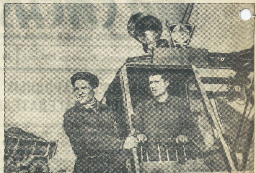
СТАЛИНГРАДГИДРОСТРОЙ. В левобережном строительном районе хорошо работает комсомольско-молодежный экипаж экскаватора братьев Булгаков. НА СНИМКЕ: машинист комсомолец В. Булгаков и бригадир И. Булгаков. Оба экскаваторщика награждены Почетными грамотами ЦК ВЛКСМ. Снимок А. Макашова (Фотохроника ТАСС).
