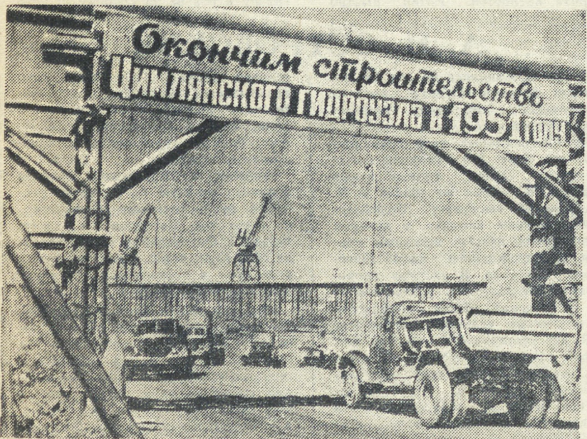
Одним из основных сооружений Волго-Донского канала является Цимлянский гидроузел. Он будет состоять из двух плотин и гидростанции. Здесь развернулись грандиозные работы. Сооружается плотина в 13 с половиной километров длины.
