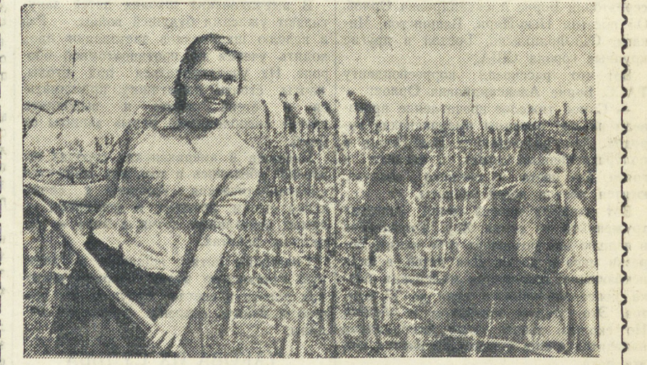
Быстро идет строительство межколхозной Погорельской электростанции. Горячо трудится здесь молодежь окрестных колхозов. Сейчас она сооружает плотину. НА СНИМКЕ: молодые колхозницы Маруся Шаршанина, Маргарита Алферова, Елизавета Ершова плетут клетки в откосах плотины. Снимок А. Мартынова.
