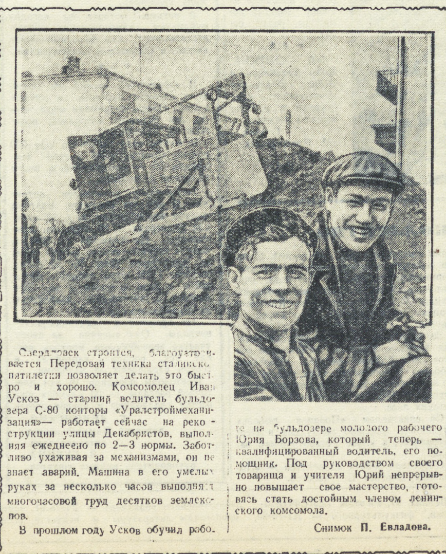
Средточек строится, благоустроивается. Передовая техника сталинских пятилетки позволяет делать это быстро и хорошо. Комсомолец Иван Усков — старший водитель бульдозера С-80 конторы «Уралстроймеханизация» — работает сейчас на реконструкции улицы Декабристов, выполняя ежедневно по 2-3 нормы. Заботливо ухаживая за механизмами, он не знает аварий. Машина в его умелых руках за несколько часов выполняет многочасовой труд десятков землекопов. В прошлом году Усков обучил рабо-
