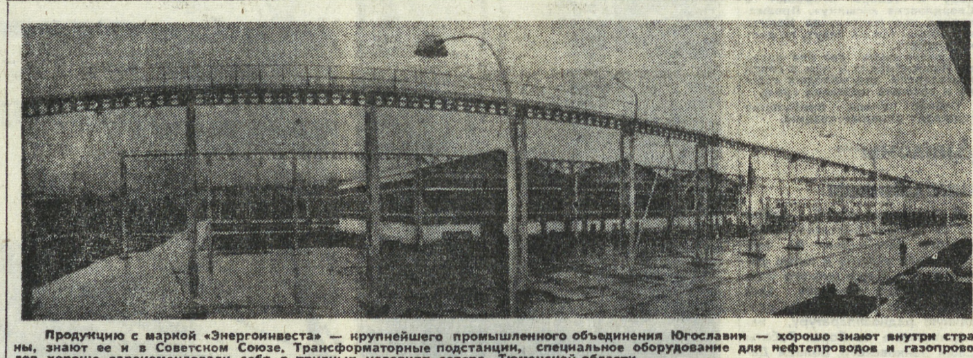
Производство с маркой «Энергоинвест» — крупнейшего промышленного объединения Югославии — хорошо знают внутри страны, знают ее и в Советском Союзе. Трансформаторные подстанции, специальное оборудование для нефтеперерады и газопроводов — продукция завода «Энергоинвест» в Добоше.
