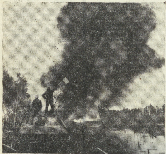
РСФСР ТЮМЕНСКАЯ ОБЛАСТЬ. Этот снимок (слева) сделан на строительстве нефтепровода Усть-Балык — Тюмень — Курган — Уфа. Аметьевский, по которому сибирская нефть пойдет на перерабатывающие заводы Поволжья и далее, по системе «дружба», в социалистические страны Европы. Строители нефтепровода траншеи для трубопровода через топиинни прокладывают взрывами. Снимок Н. САПОЖНИКОВА. УСТЬ-ИЛИМ. Кому не знакомо это название! Со всех концов страны съезжались в Сибирь молодые, чтобы построить в нехоженой тайге энергопромышленный комплекс (снимок справа). Покорители тайжного края борются за успешное выполнение трудовых обязательств в честь 50-летнего юбилея СССР. В нынешнем году они хотят уложить в плотную гидротраншею 500 тысяч кубометров бетона. Снимок Э. БРЮХАНЕНКО. Фотохроника ТАСС.
