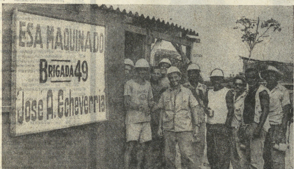
КУБА. В окрестностях Гавамы на берегу морского залива создается крупный жилой район — новостройка Аламар («К морю»). Здесь на стройке трудятся рабочие — добровольцы промышленных и сельскохозяйственных предприятий провинции Гавамы.
