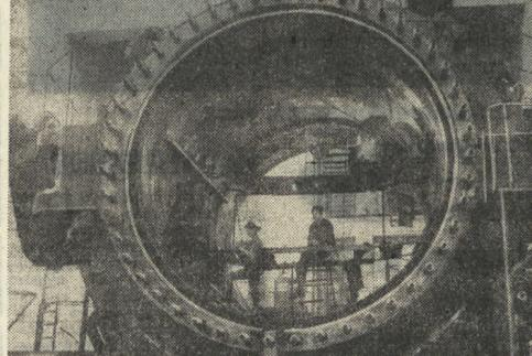
На Харьковском ордена Ленина турбинном заводе имени Кирова закончено изготовление первого шарового гидрозатора для Нурекской ГЭС (Таджикская ССР). Эта гигантская задвижка весом около 600 тонн и диаметром свыше четырех метров предназначена для перекрытия напорного трубопровода. На снимке: затвор в гидротурбинном цехе завода.
