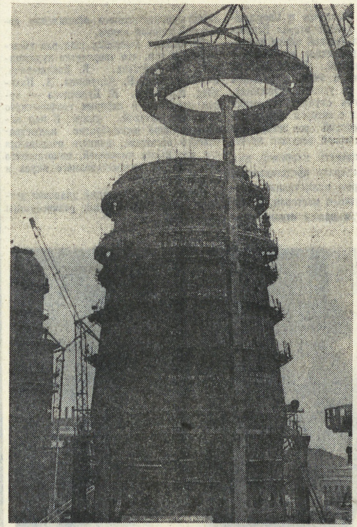
На Новолипецком металлургическом заводе полным ходом идет сооружение литейной печи. Объем ее печи составит 3200 кубометров. Возводит новую печь коллектив треста «Ипещстрой». Применяя передовые промышленные методы, строители строго выдерживают график работ. Домна войдет в строй действующих в ноябре 1972 года. На снимке: идет монтаж шахты печи. Фотохроника ТАСС.
