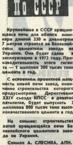
Крупнейшая в СССР вращающаяся печь для обжига клинкера длиной 230 и диаметром 7 метров строится на Балаклейском цементном заводе на Украине. Она будет сдана эксплуатацию в 1972 году. Производительность этого гиганта — 1 миллион 200 тысяч тонн цемента в год.
