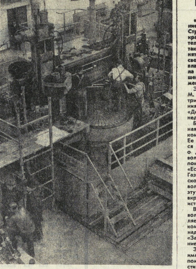
Это не просто себе представить: станок высотой с 4—5-этажный дом! Такие gigantesкие металлообрабатывающие станки выпускает подмосковный Коломенский завод тяжелого станкостроения.
