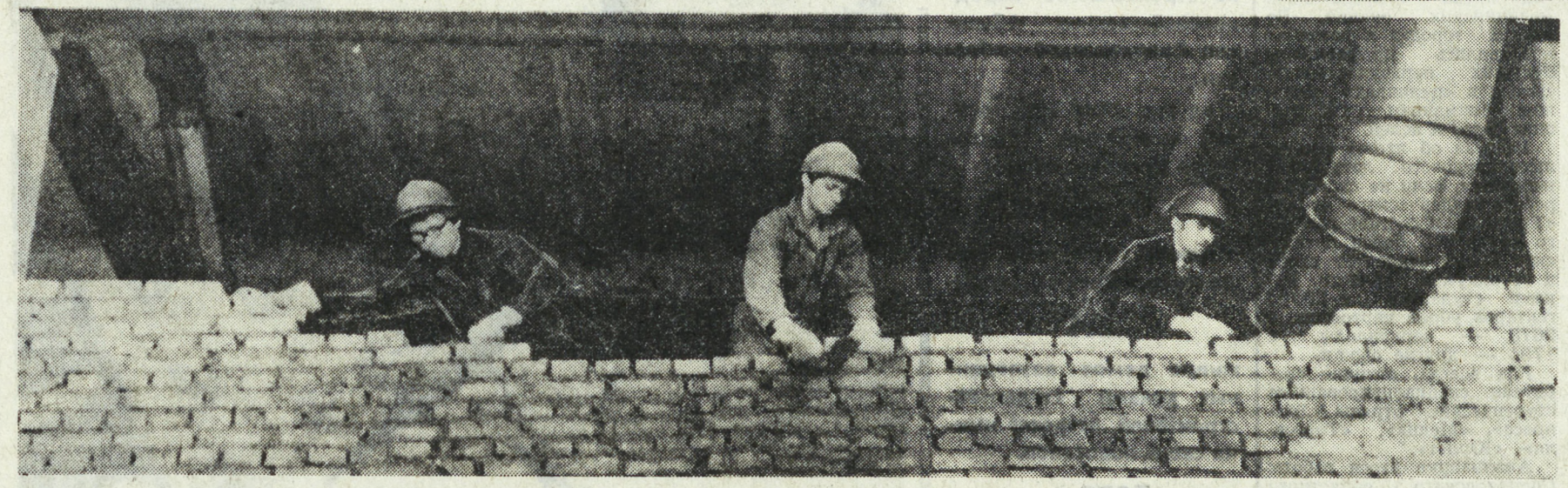
Бойцы отряда «Гиперон» Уральского государственного университета трудились на строительстве нового цеха Буланашского машиностроительного завода. Особенно удачно поработали ребята из бригады кровельщиков Константина Демидюка. Кровлю нового корпуса они выполнили гораздо раньше намеченного срока. На снимках: кровельщики Виктор Быков и Валерий Павлов; кладку ведут Вадим Обрин, Борис Киселев и Анатолий Груберман. Снимки А. ЛАПТЕВА.
