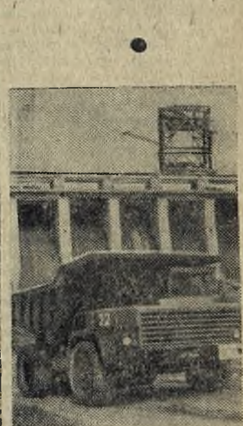
Запорожье. Ускоренными темпами ведется строительство электростанции «Днепрогэс-2». Скоро начнется укладка бетона в основание станции. Важнейший объект стройки — котлован, здесь предстоит выкопать 16000 кубометров скальных пород. Мощные экскаваторы и самосвалы ведут выемку грунта на трассе нового судоходного шлюза. На снимке: на сооружении котлована. Фото А. Красовского. (Фотохроника ТАСС).
