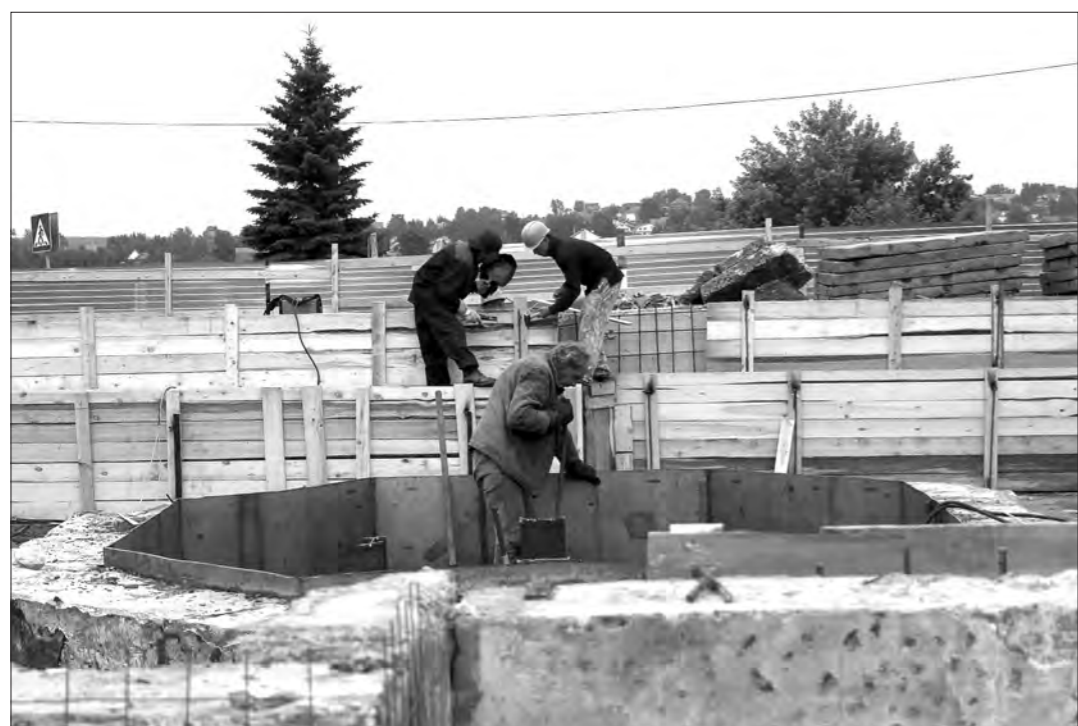
Реконструкция чаши фонтана «Каменный цветок».
