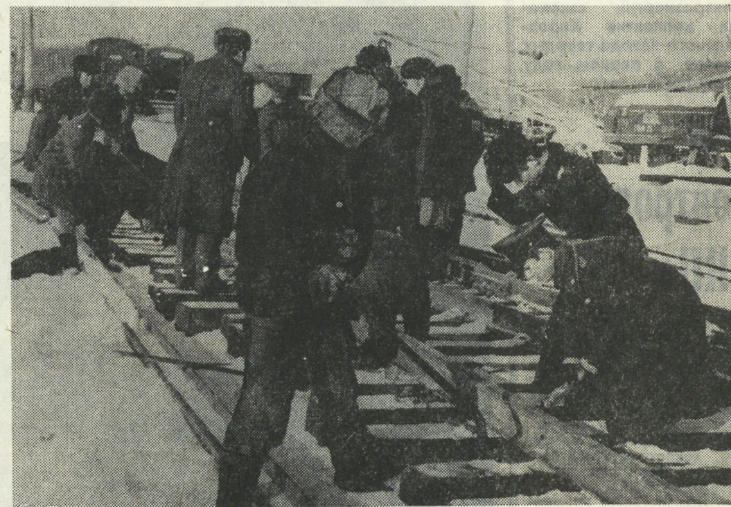
На снимке: укладка «пограничного» звена на Байкало-Амурской магистрали. Снимок В. СЕМЕНОКА.
