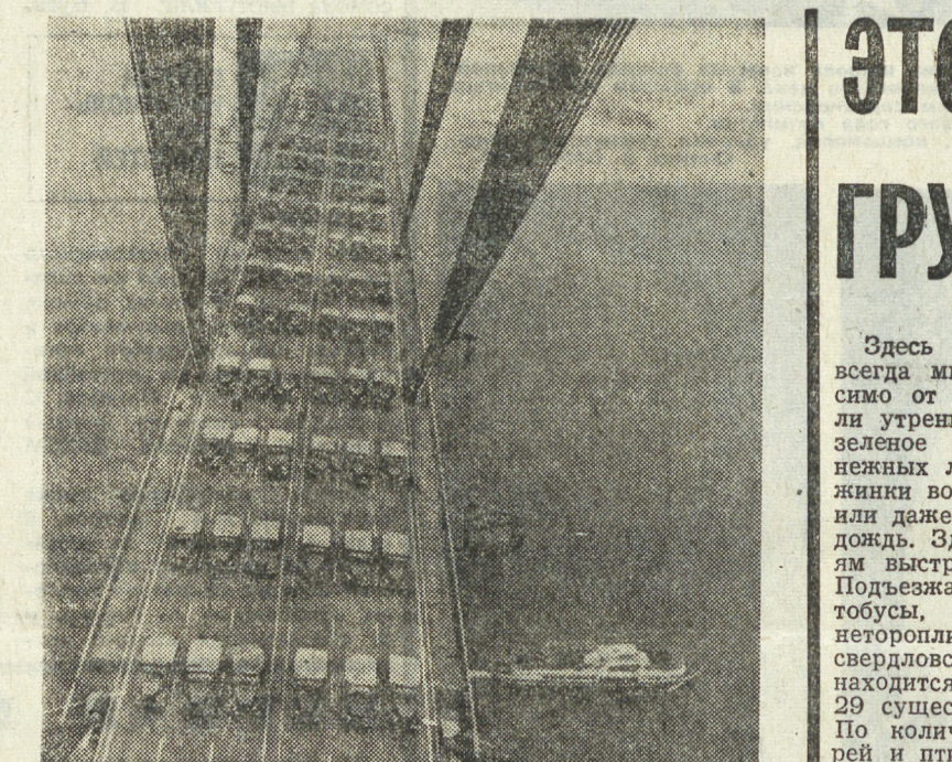
УКРАИНСКАЯ ССР. В Киеве построен крупнейший в Советском Союзе вантовый мост. Главный пролет гигантского сооружения протяженностью 300 метров как бы парит над Днепром. Ширина его проезжей части достигает 30 метров. Шестой по счету вантовый мост вливается в систему окружной дороги, замыкая ее кольцо вокруг самого крупного жилого массива — Оболонь. Связав кратчайшим путем густонаселенные районы и зеленую зону, он дает возможность разгрузить транспортный поток в черте города. Строительство уникального инженерного сооружения закончено почти на месяц раньше срока. НА СНИМКЕ: новый мост держит экзамен на прочность. (Фотохроника ТАСС).
