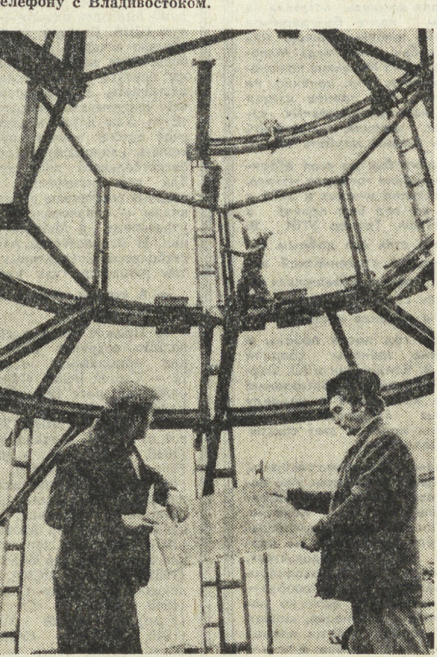
На снимке: строительство наземной приемной станции, строящейся сейчас в Таландереде.
