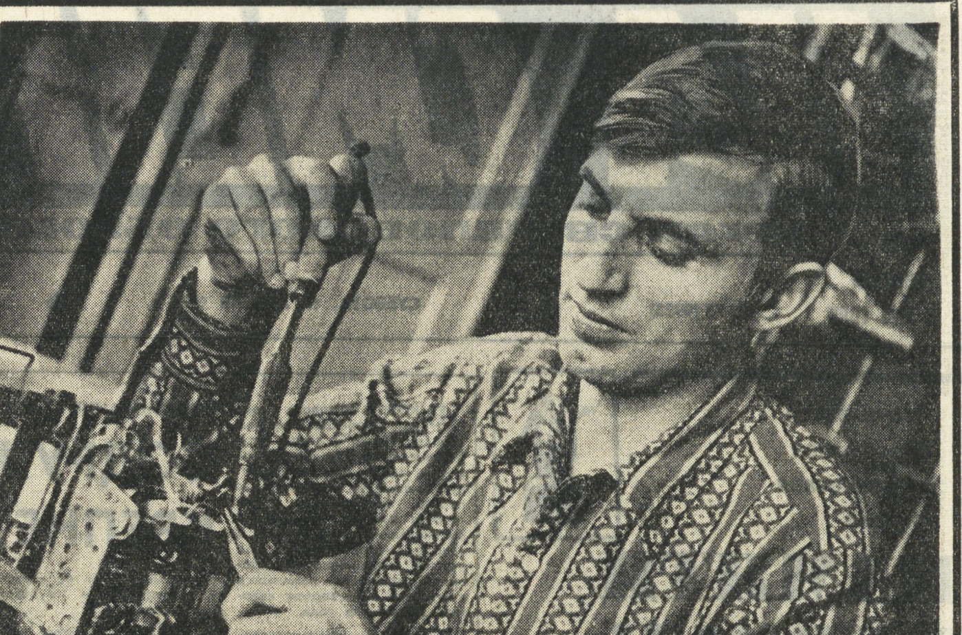
Утром, придя на работу, Леонид в Васильеве в журнале станционных поверждений увидели запись «Не работает техническая сигнализация». Полюшка была обнаружена в состоянии жидкости. Оказался неисправным жидкий искатель. Ребята быстро устранили дефект, все каналы телефонной станции пришли в действие. Этот эпизод — маленький штрих в повседневных делах Леониды и Василия. Молодые связисты АТС олеупного производства Л. Путищева и В. Бурнышев любят свое дело. Работают они
