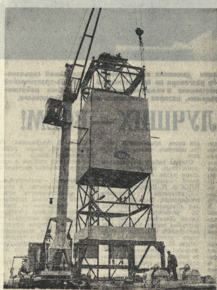
На снимке: установка для шпаклевки глубиной 15 тысяч метров. Фото В. Калинин, (АПН).
