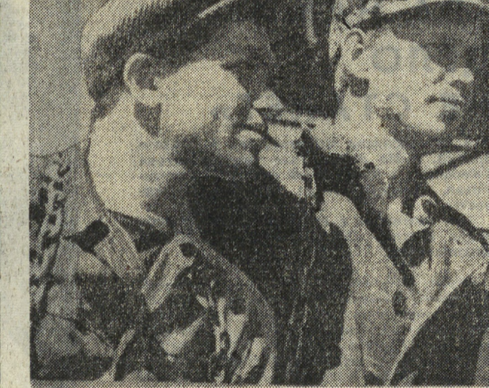
Хорошо работают на строительстве волоочильного цеха Синарского трубного завода — ударной комсомольско-молодежной стройке — монтажники-верхолазы управления «Уралстальконструкция».
