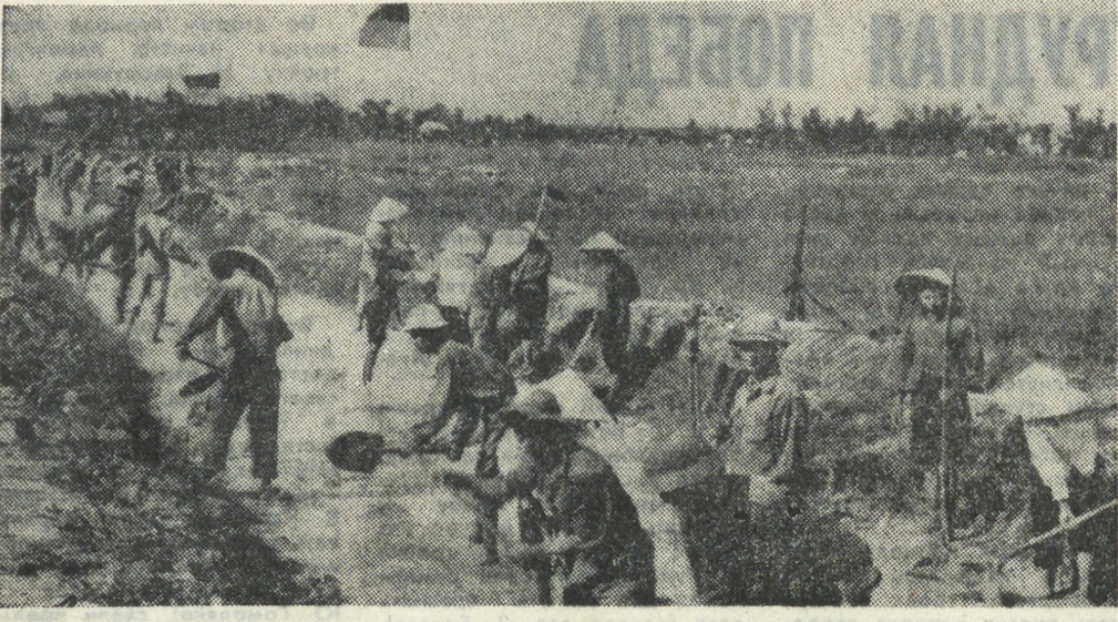
Южный Вьетнам. Винтовки, поставленные у обочины, шлемы среди традиционных соломенных шляп — это бойцы НВСО пришли на помощь крестьянам провинции Куангчи, которые восстанавливают ирригационные сооружения, готовясь к посевной кампании зимнего и весеннего сезонов (на снимке).
