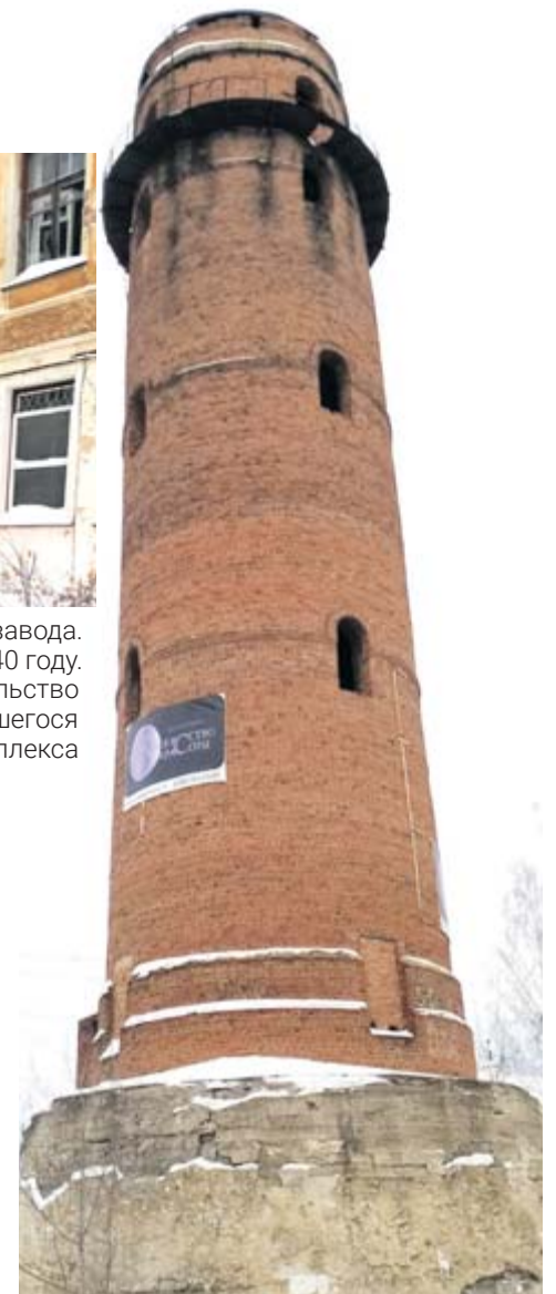
Водонапорная башня на одном из фундаментов, заложенных в 1940 году для доменной печи несостоявшегося завода
