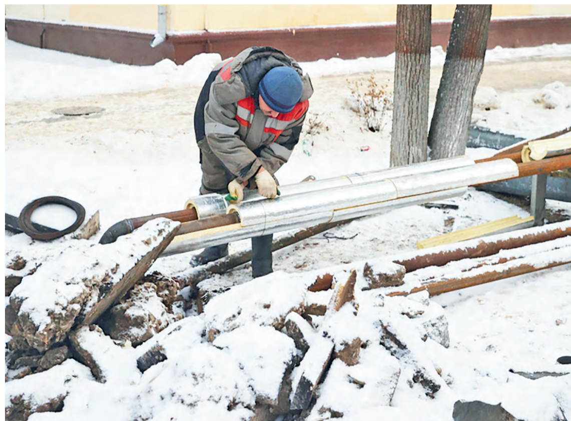
В Подольске без тепла осталось 176 домов
