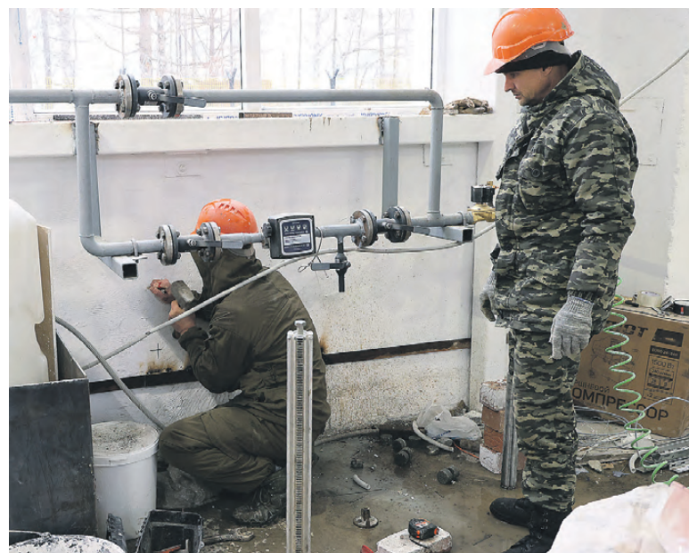
Монтаж оборудования в котельной на улице Высокогорской.
