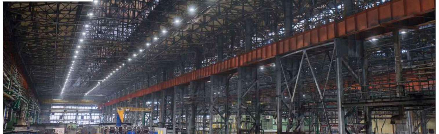
Старые демонтированные светильники
