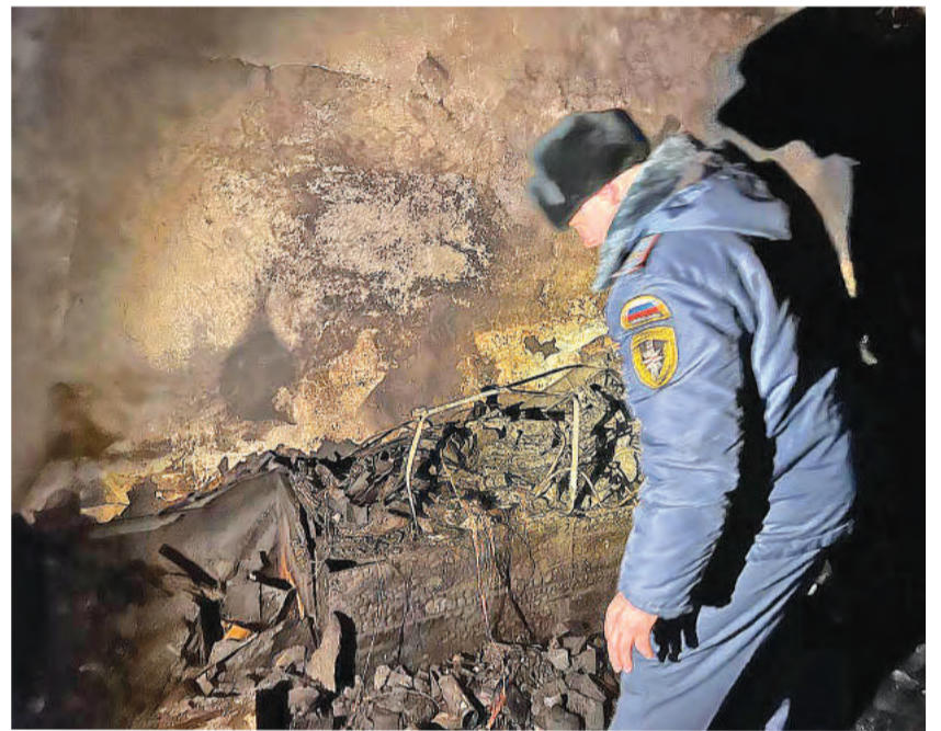
Огнём уничтожено практически всё имущество в квартире.
