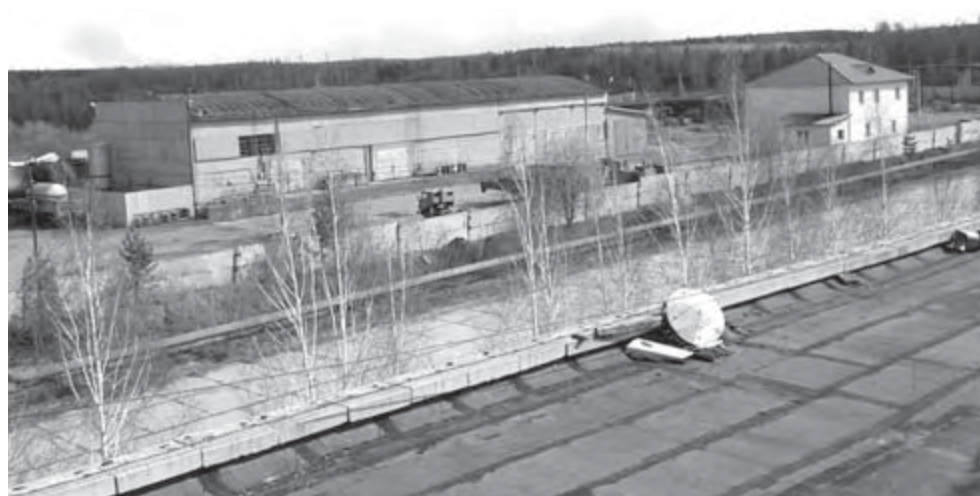
Начало строительства Алапаевского металлургического завода (НАМЗ)
