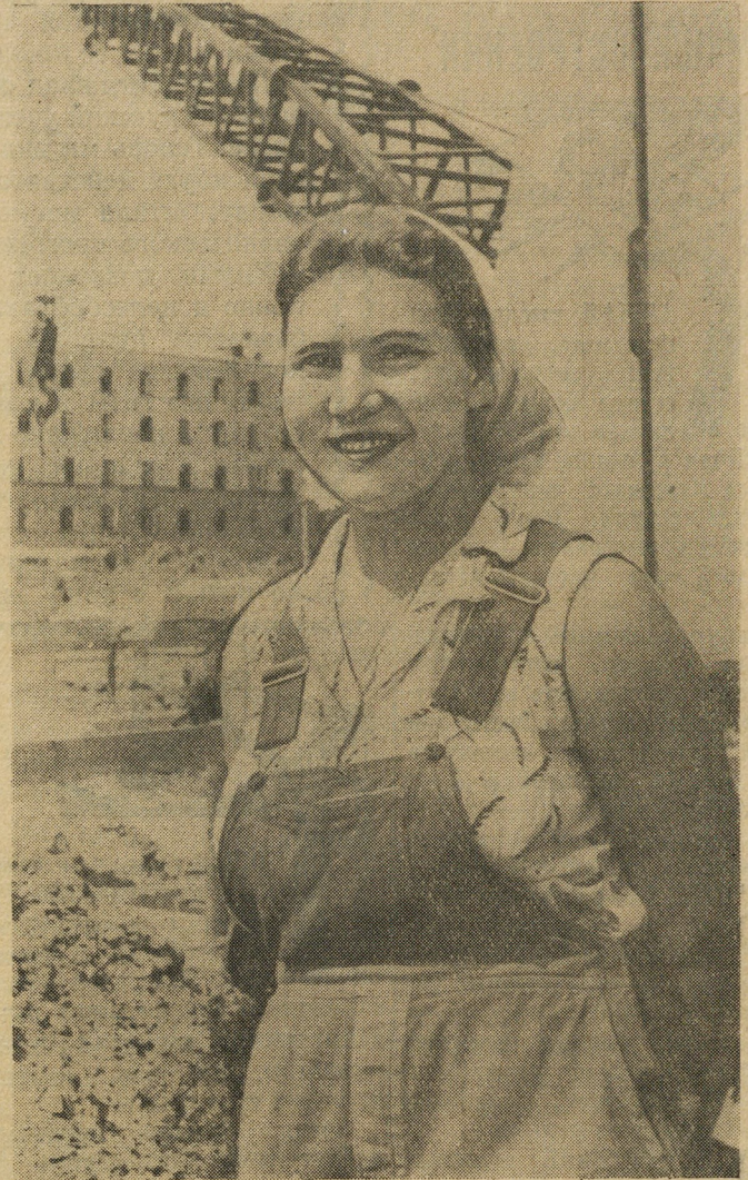
На показательной стройке довольны работой комсомолки Тамары Немихиной, которая трудится строповщицей в 358 управлении «Уралтрансспецстрой».
