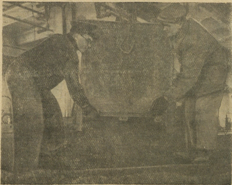
На Нижне-Исетском заводе железобетонных изделий треста «Стройдеталь-70» заслуженной славой пользуется в коллективе бригада бетонщиков, которой руководит Николай Чурсин.
