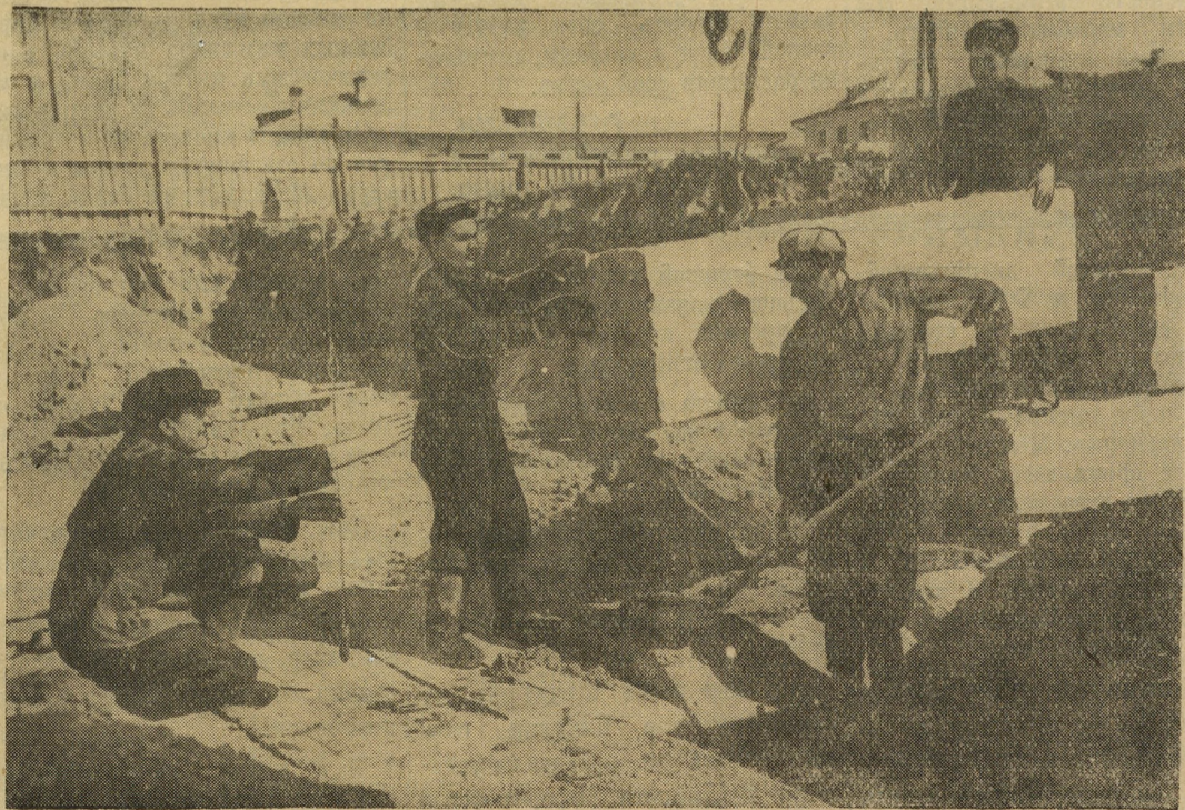
На улице им. Грибоедова в поселке завода Уралхиммаш коллектив первого участка треста «Южгорстрой» приступил к строительству многоквартирного дома № 270. Монтаж фундаментных блоков ведет бригада тов. Писарчука.
