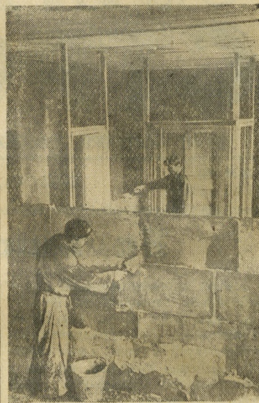
На скоростном строительстве дома в десятом квартале Урла-маша устанавливаются межкомнатные перегородки из шлакоалебастровых плит.
