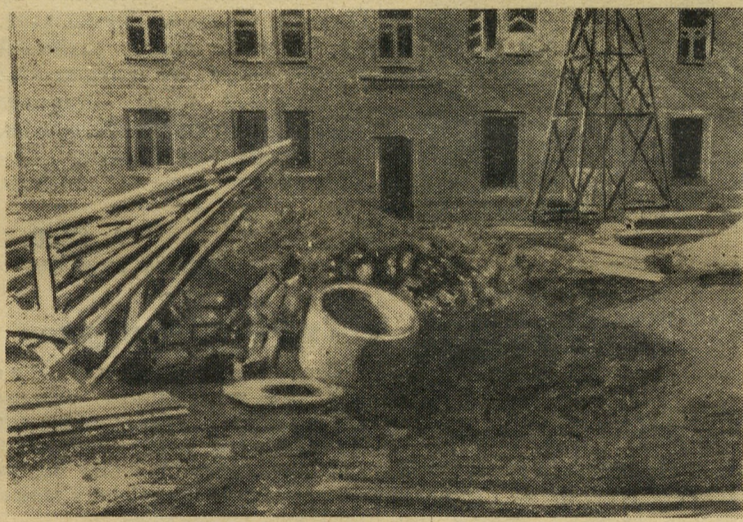
На площадке возле дома № 5.
