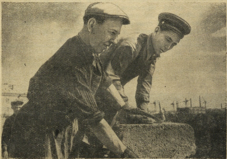
Быстро вырастают дома в 59 квартале Уралмаша. НА СНИМКЕ: бригадир каменщиков И. Ф. Матвеев с подручным Н. Муртаковым ведут кладку на первом доме.
