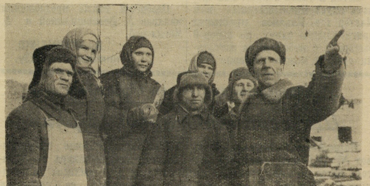
На строительстве 59 квартала Уралмаша. Бригадир каменщиков И. Матвеев беседует со своей бригадой.
