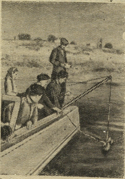
Сталинград. На месте предстоящей стройки Сталинградской гидроэлектростанции на реке Волге развернулись изыскательские работы.
