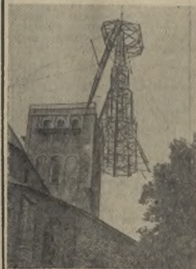
Эстонская ССР. Тысячи таллинцев стали свидетелями необычного зрелища: на их глазах на башню восстановленной после войны церкви Нигулисте был водружен 50-метровый шпиль. Операцию по заказу эстонских реставраторов осуществили ленинградские монтажники.
