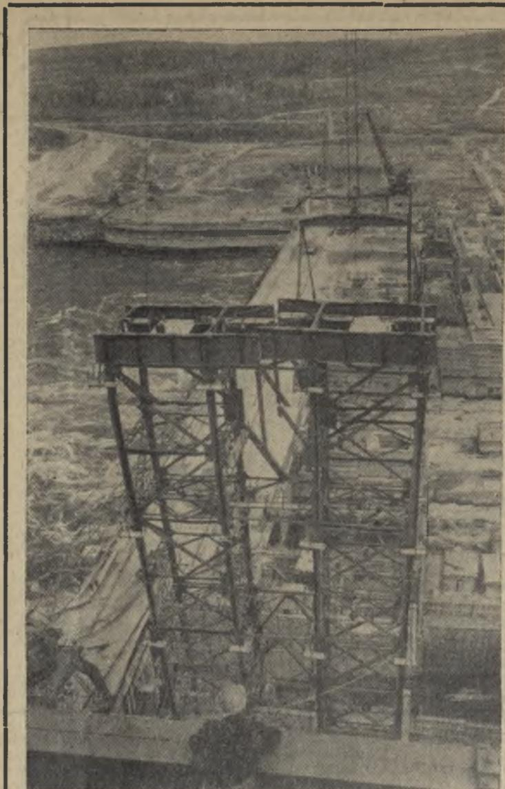
Иркутская область. Полным ходом идет строительство Усть-Илимской ГЭС. Ведется подготовка к бетонированию плотины и фундамента под здание станции, монтируется большая бетоновозная эстакада готовится к пуску второй, более мощной бетонной заливки.
