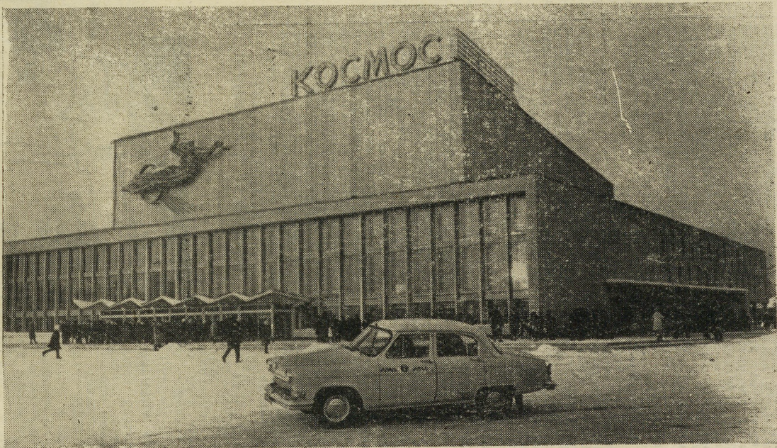
Прошло больше года с тех пор, как утих строительный шум в залах «Космоса». Теперь это одно из красивейших зданий города, которое полюбили свердловчане и непременно осматривают приезжие. Но больше всего оно, конечно, дорого тем, кто соорудил его своими руками. Фото О. КАПОРЕЙКО.
