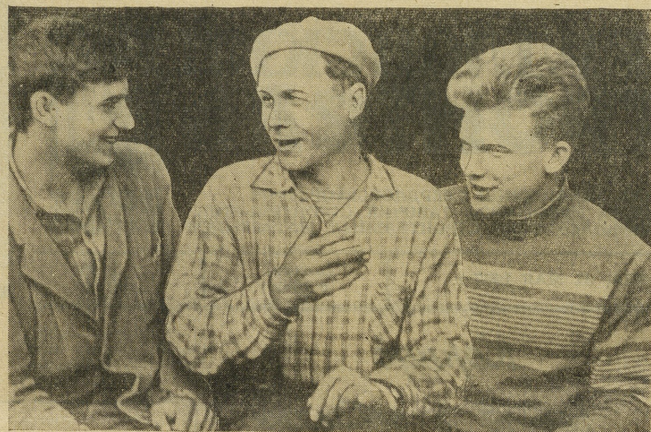
Эти трое работают на сооружении ремонтного трамвайно-троллейбусного завода. Ю. Овчинников и Н. Жуланов — опытные плотники, имеющие большой стаж. А Х. Ходжиев еще совсем молод. В прошлом году он окончил одиннадцать классов. Работа не мешает ему успешно учиться на заочном отделении института народного хозяйства.
