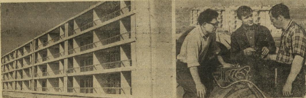
«Землетрясению» силой более восьми баллов было подвергнуто только что отстроенное крупнопанельное здание в Душанбе. Произведено оно было с помощью мощной вибрационной машины, созданной в лаборатории прочности Центрального научно-исследовательского и проектного института типового экспериментального проектирования жилища.
