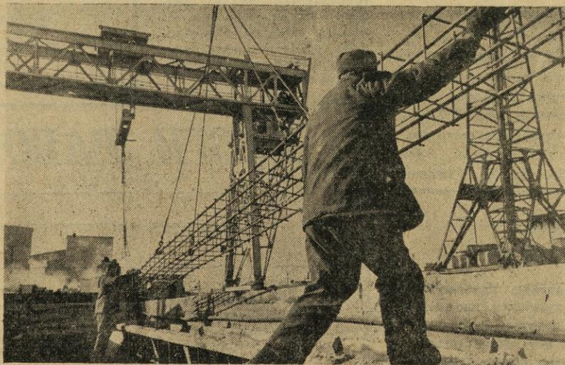
Еще немного и металлические линии каркаса будут залиты бетоном. А потом ферма навечно ляжет под перекрытие нового цеха. Еще одна, еще одна...
