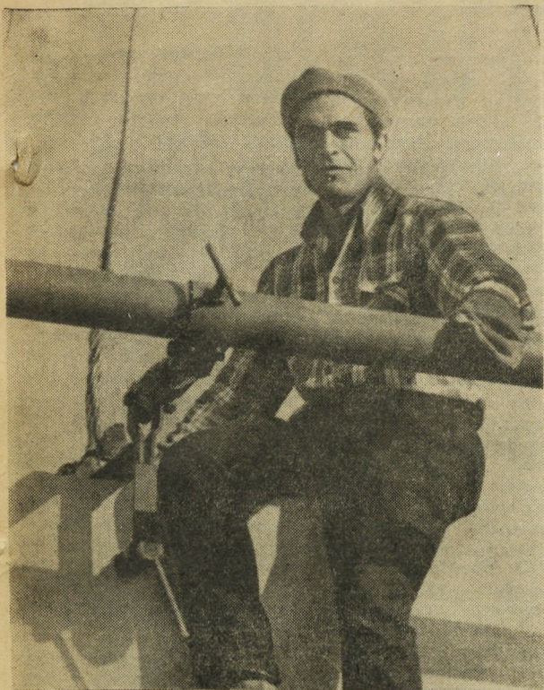
После армии пришел Виктор Лазарев на стройку. Сейчас он работает в строительном управлении № 27, Домостроительного комбината.
