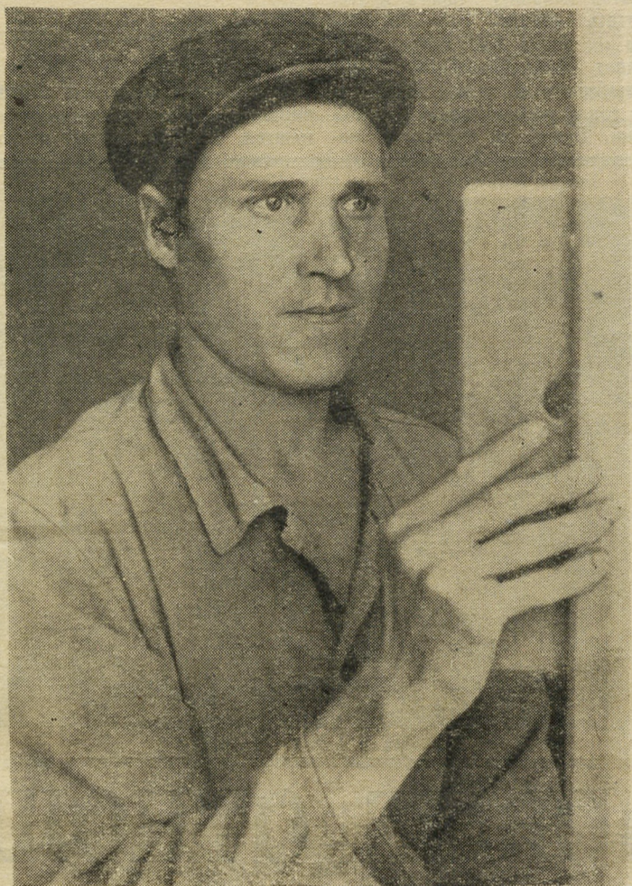
Василий Мошкалев, плотник из бригады Павла Якшина, хорошо зарекомендовал себя на первом участке управления Жилстрой.
