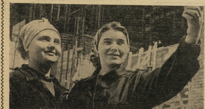
Бригада штукатуров шестого управления М. Малыгина работает на строительстве научно-исследовательского электротехнического института. С заданием справляется успешно. На снимке (слева направо): члены бригады Л. Двойникова и Р. Павлова. Фото Н. Максимова, плотника.
