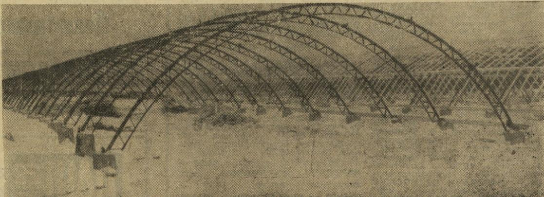
На снимке вы видите законченный монтаж конструкций теплицы с совмещенным верхним отоплением в Орджоникидзевском совхозе. Это новинка в сельском строительстве.
