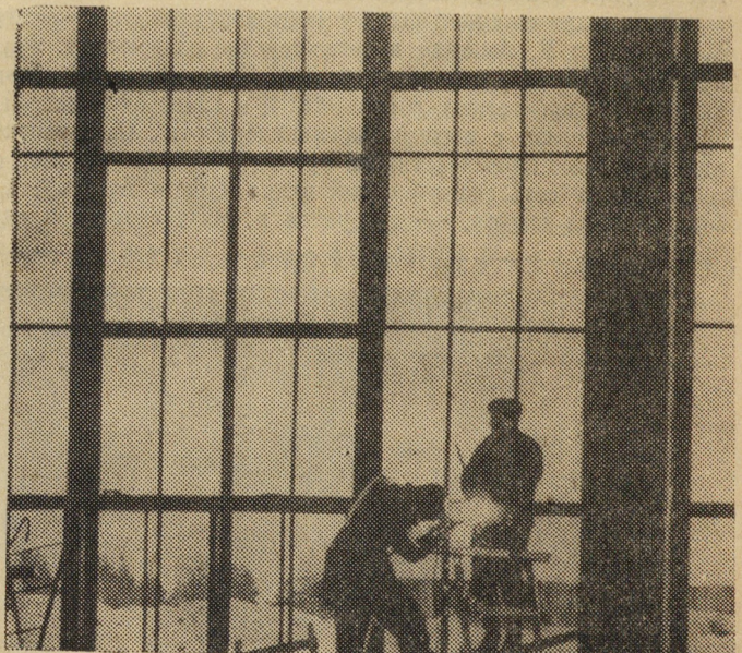
В конце этого года войдет в строй на Уралхиммаше блок цехов тяжелой химической аппаратуры. На снимке: монтаж оконных переплетов. Фото А. Нагибина.
