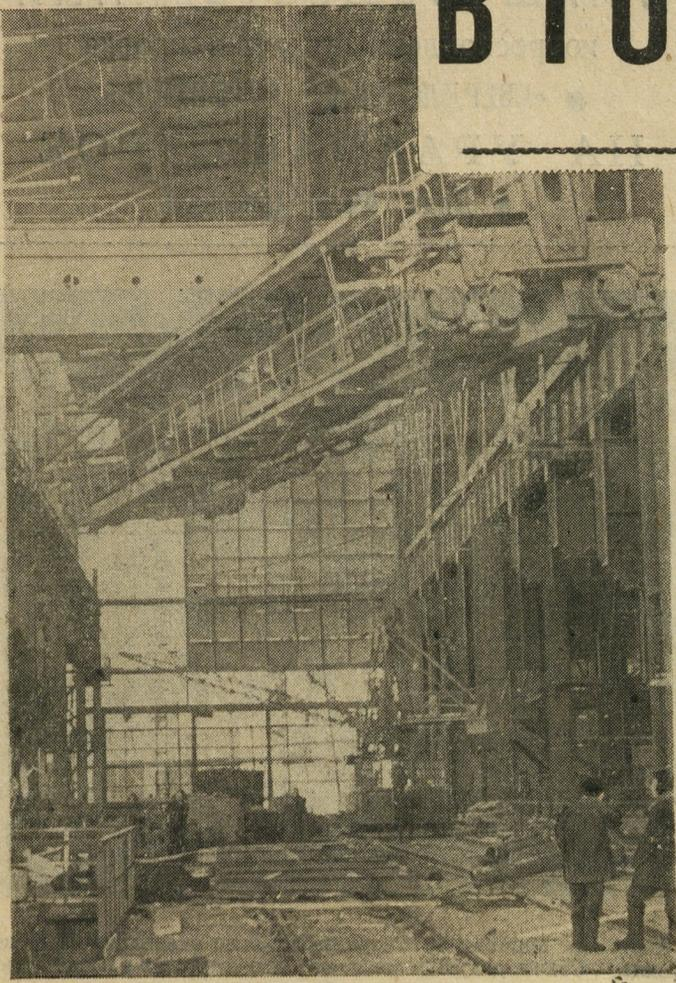
Подъем мостового крана в 55 тонн в главном корпусе конверторного цеха НТМК. Подъем ведет передовая бригада монтажников «Востокметаллургмонтаж» А. П. Сербинова.
