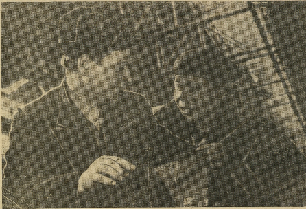
На нашем снимке передовые сварщики-монтажники 24 строительного управления Уралмашстроя Георгий Иванович Грачев (слева) и Эдуард Николаевич Иваницкий. Фото М. Арутюнова.
