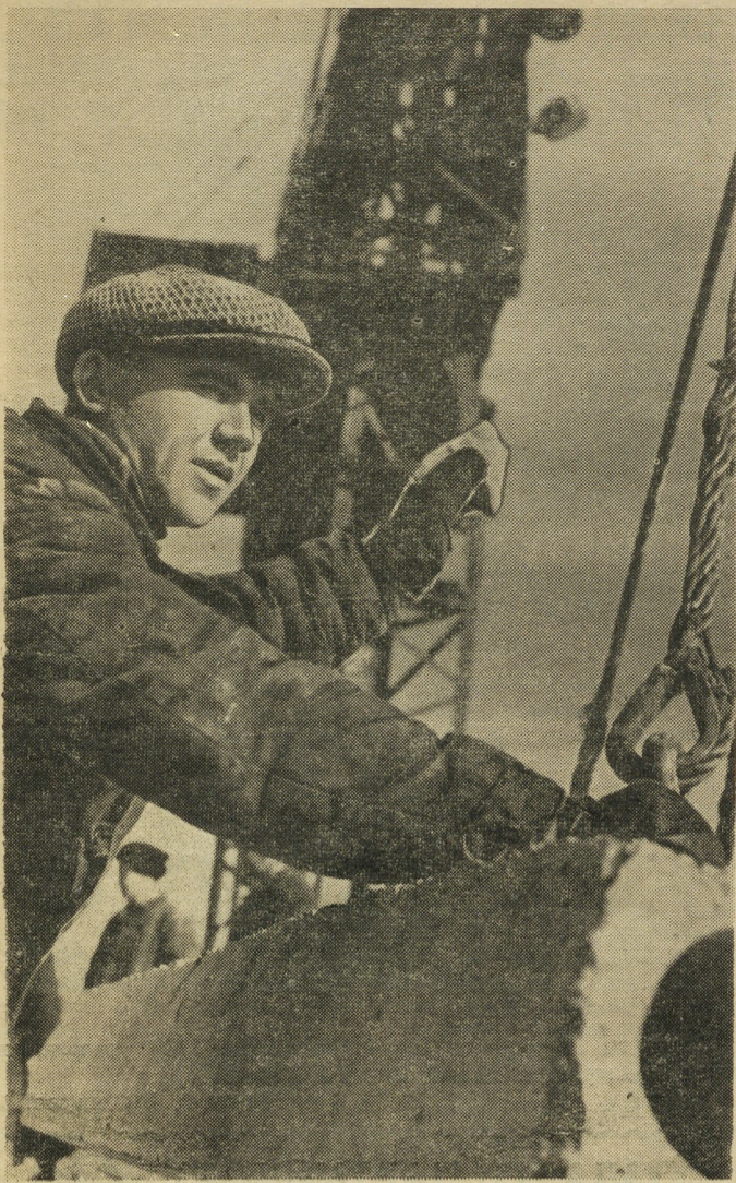
На снимке: Н. Ф. ГУШИН — передовой монтажник 13 управления треста Южгорстрой, занятый на строительстве крупнопанельных домов в 21 квартале.
