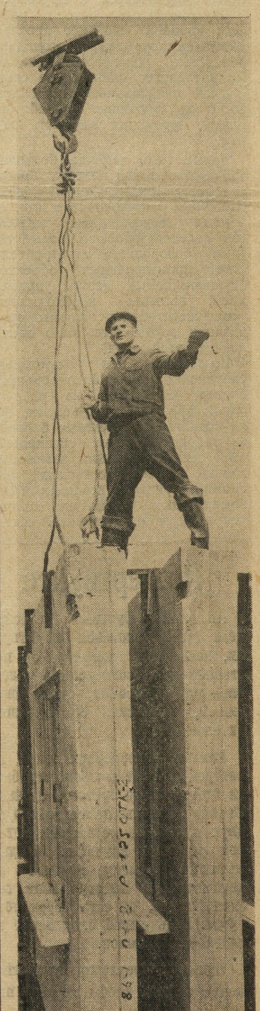
На снимке: Геннадий Константинович Маслаков — передовой стропальщик завода ячеистых бетонов треста Стройдеталь № 70 за погрузкой изделий на жилые дома, строящиеся по циклограмме. Фото М. Арутюнова.
