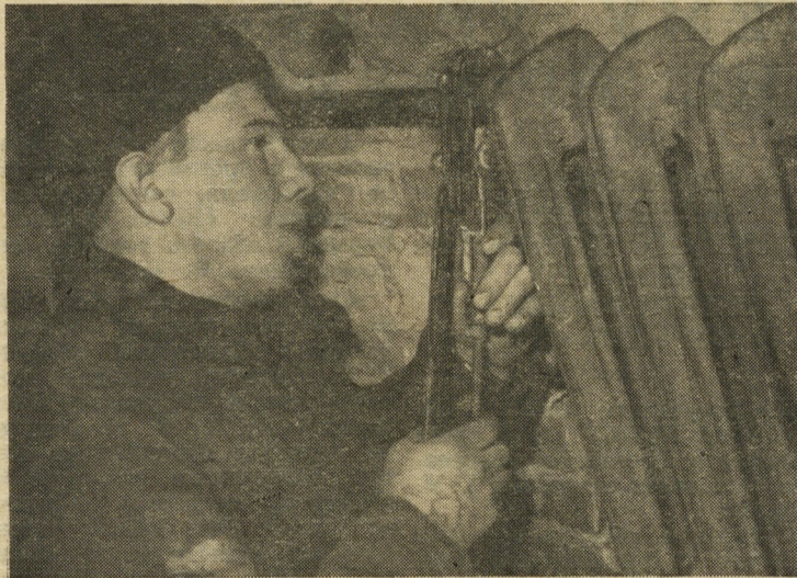
Передовой слесарь-сантехник из первого управления треста «Уралсантехмонтаж» Юрий Васильевич Вахонин за монтажом отопительной системы в помещении торговой вставки в пятом квартале Вторчермета, где строительство домов ведет трест «Южгорстрой».
